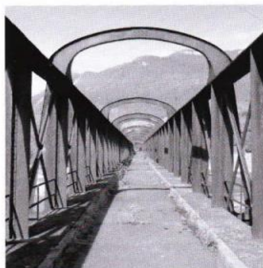
Figura 13. Ponte a Cruet: vista della travata reticolare continua (Association Cruet Nature et Patrimoine).
