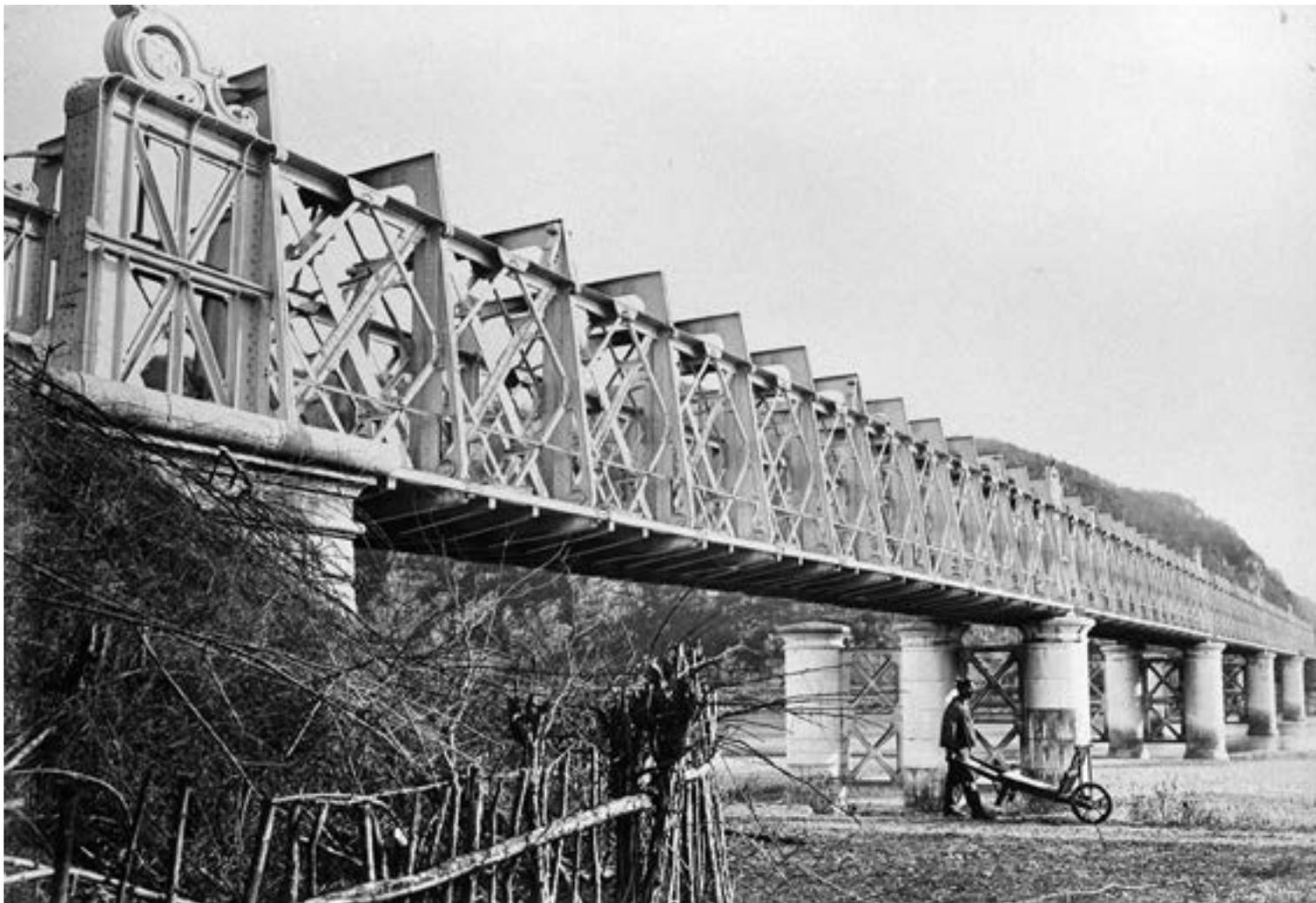
Fig. 14 | Ponte a Culoz: vista dei tubi in ghisa a tutt'altezza e delle travature reticolari (Ministère des travaux publics, 1873).
